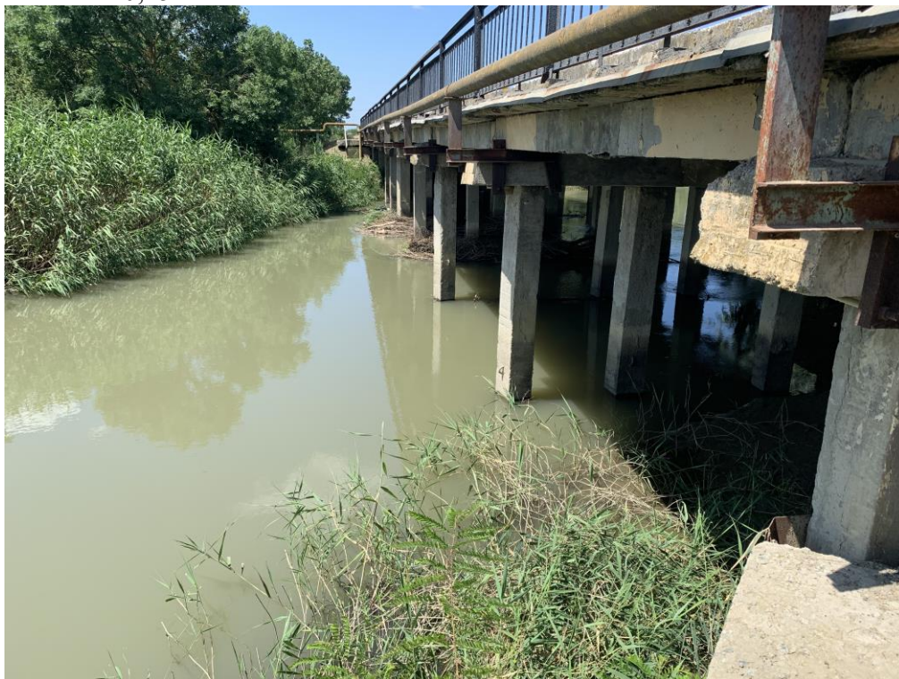
Рисунок 6.8 - Мост через канал АГОС 1 в ст. Гривенской
